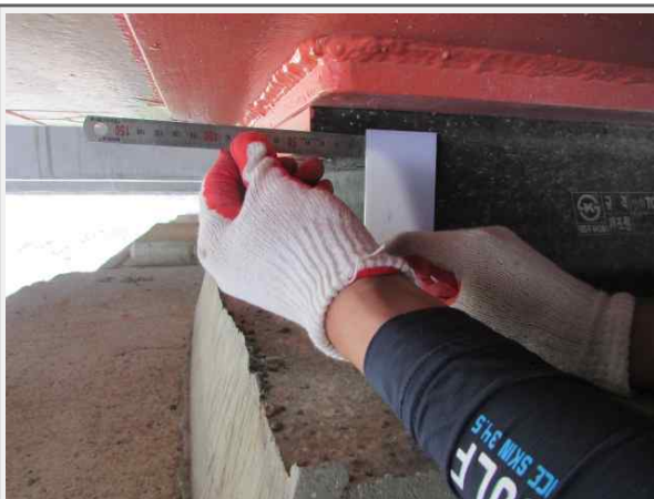
P8 교량반침 이동량 측정(상주)
