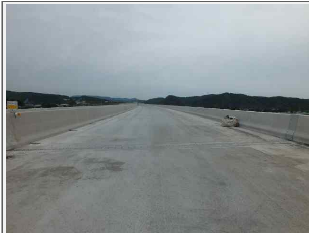
내 용 산하교(영천) 상부
