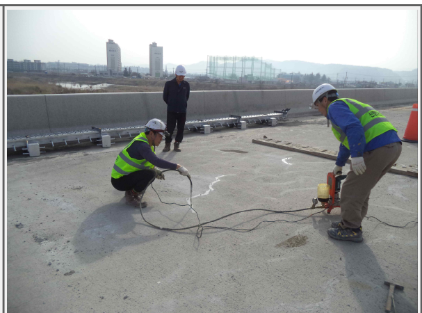
내 용 바닥판 균열보수 현황
