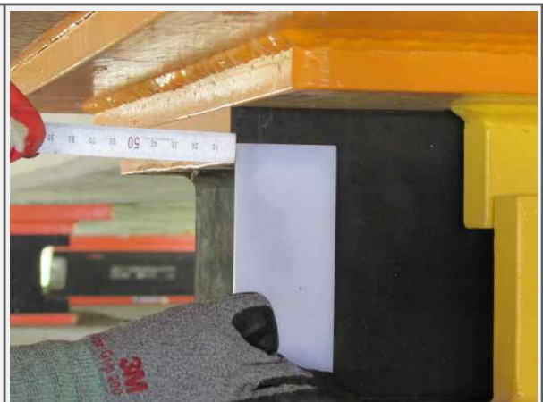
P1 교량반침 이동량 측정(영천)
