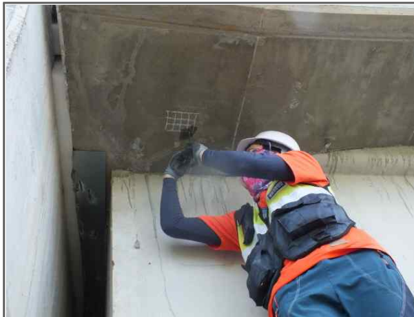
상부구조 탄산화깊이 측정
