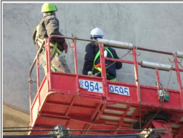
내 용 교각 코핑부 균열보수 현황
