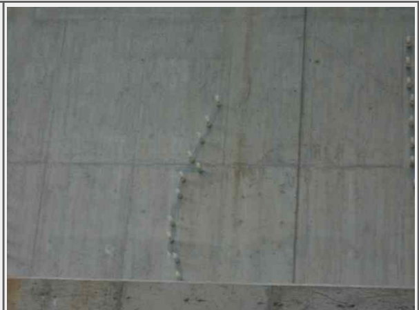
내 용 교대 균열 수지주입 보수
