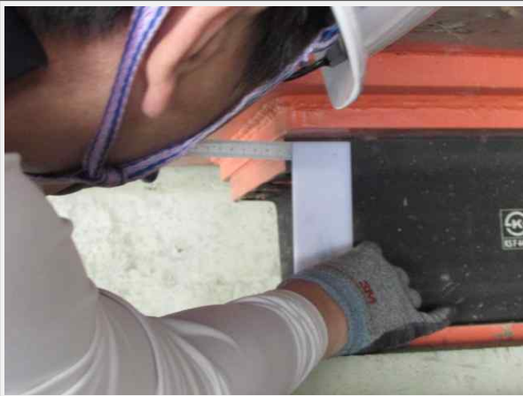
A1 교량반침 이동량 측정(상주)
