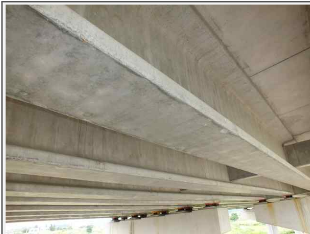
내 용 산하교(영천) 거더
