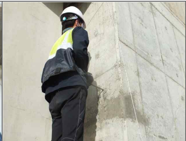
하부구조 탄산화깊이 측정
