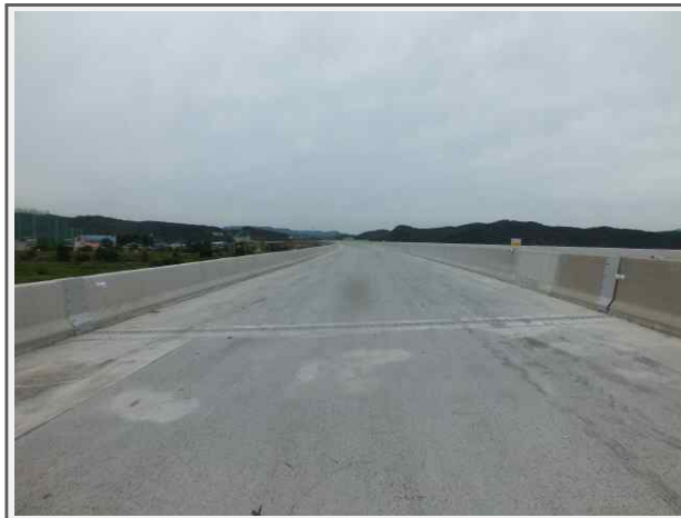
내 용 산하교(상주) 상부
