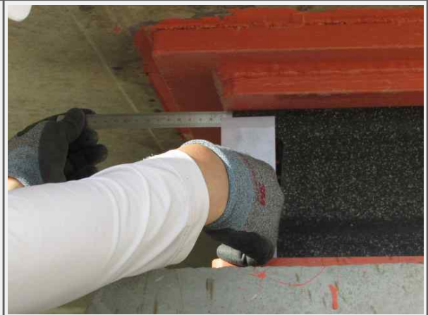
A2 교량반침 이동량 측정(영천)
